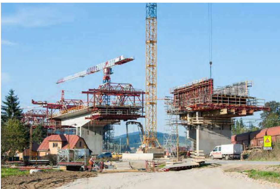
Obr. 6 Pohľad na výstavbu komorovej konštrukcie
