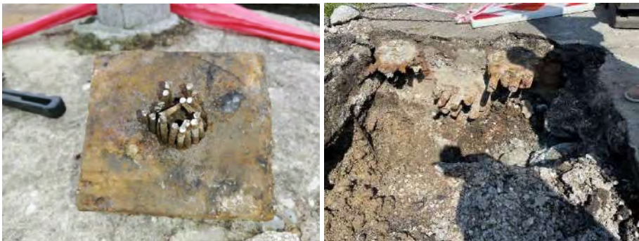
Obr. 4 – Detail odobratej kotvy (vľavo), kotevná oblasť (vpravo).
