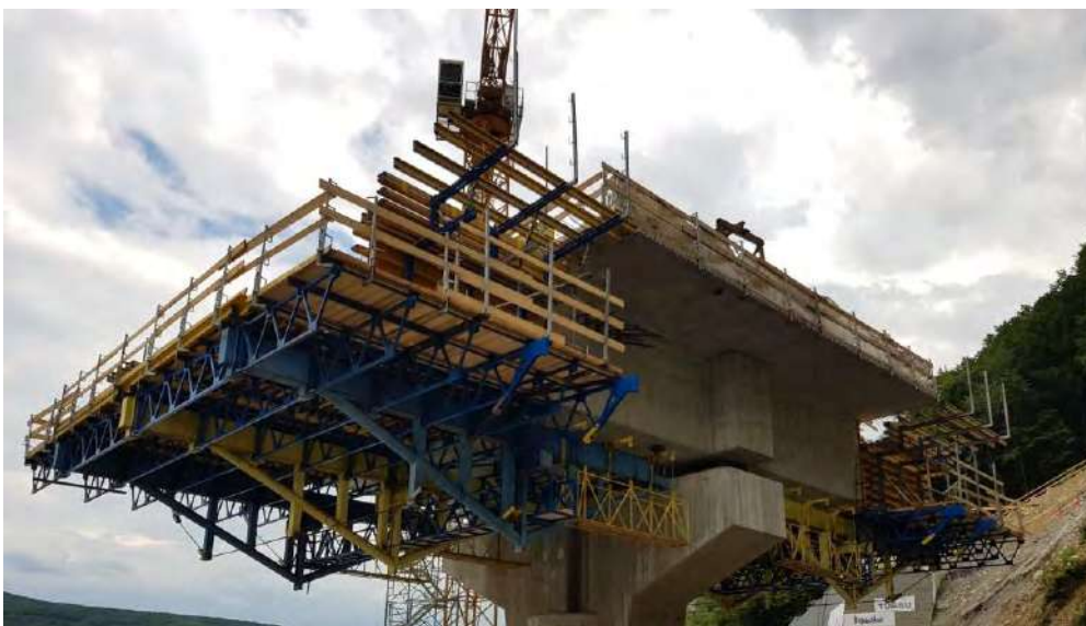
Obr. č. 5 Montáž vozíkov letmej betonáže
