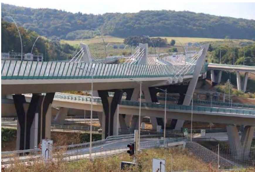
Obr. 6 Pohľad na dokončený mostný objekt 201-00
