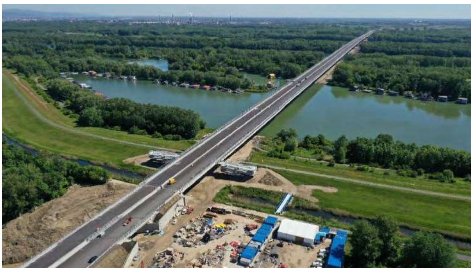
Obr. 1 Letecký pohľad na Dunajské súmostie - Lužný most
