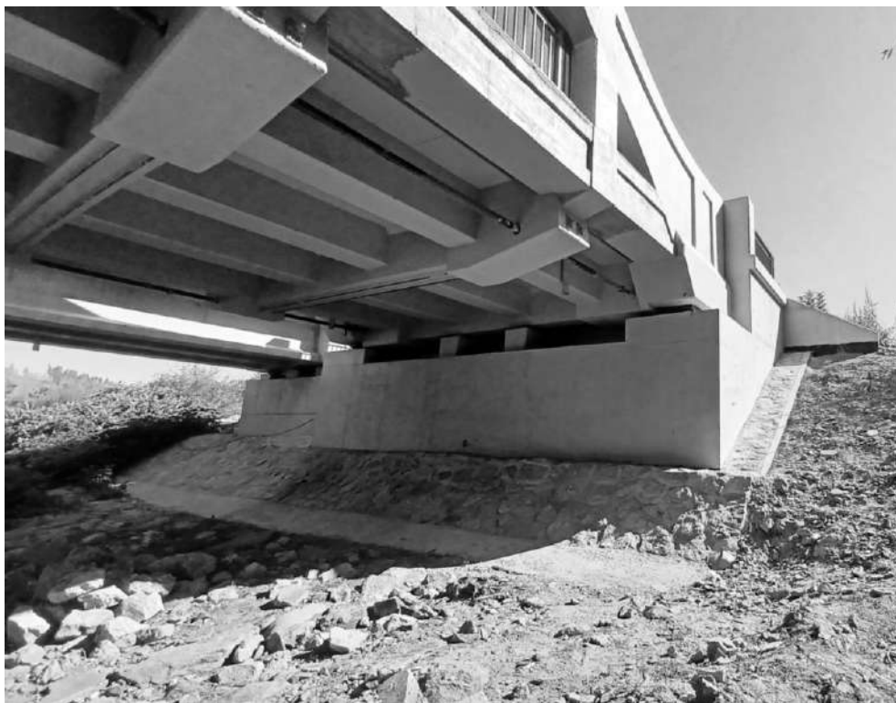
Obr. 4 Pohľad na oporu
