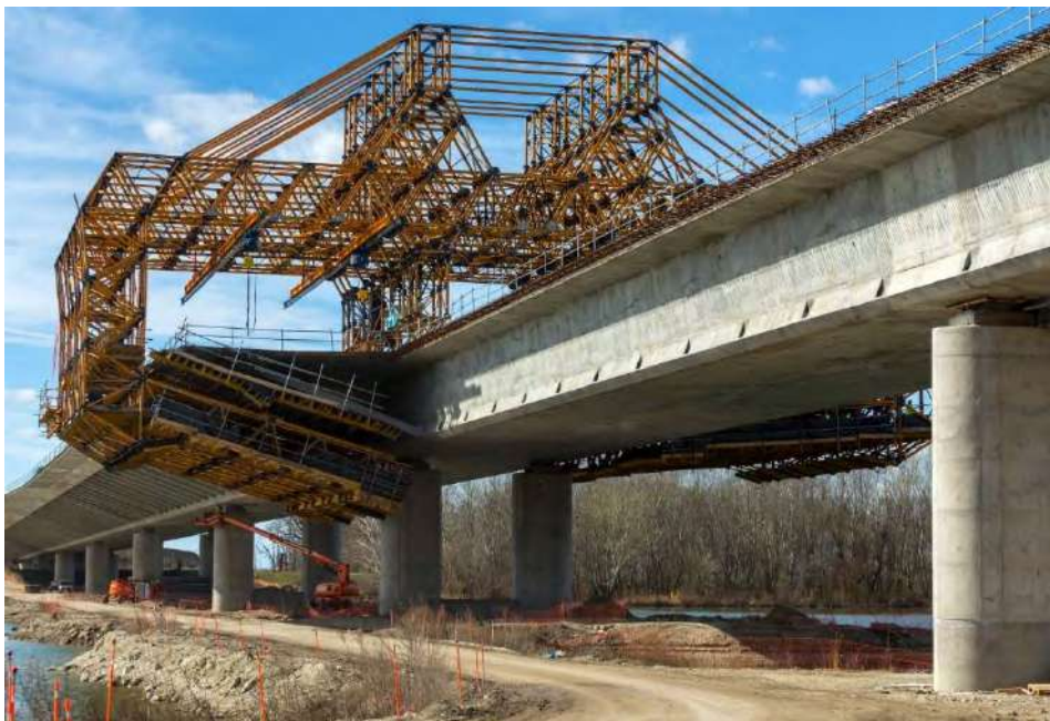
Obr. 4 Výstavba konzol nosnej konštrukcie pomocou posuvnej skruže
