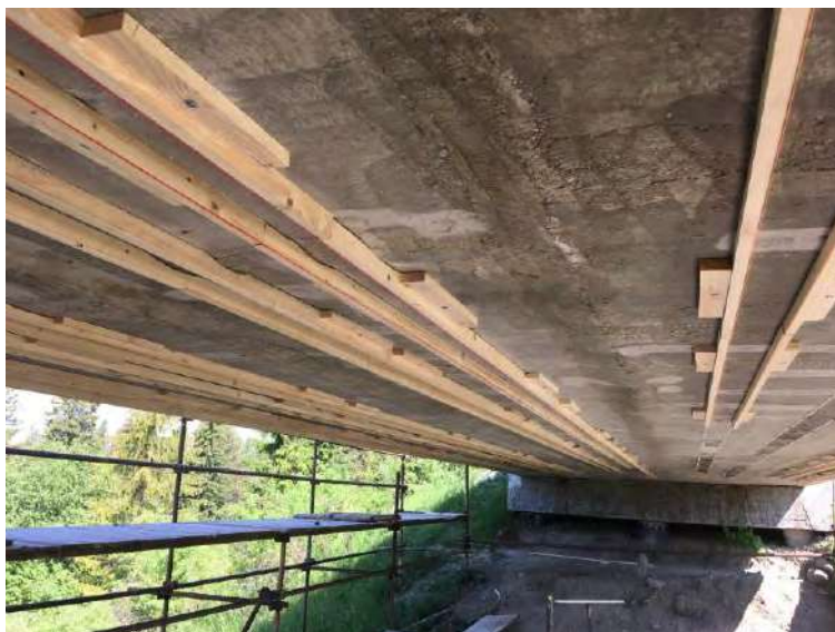
Obr. 1. Príprava priestoru na sanáciu podkladu pred zosilňovaním
