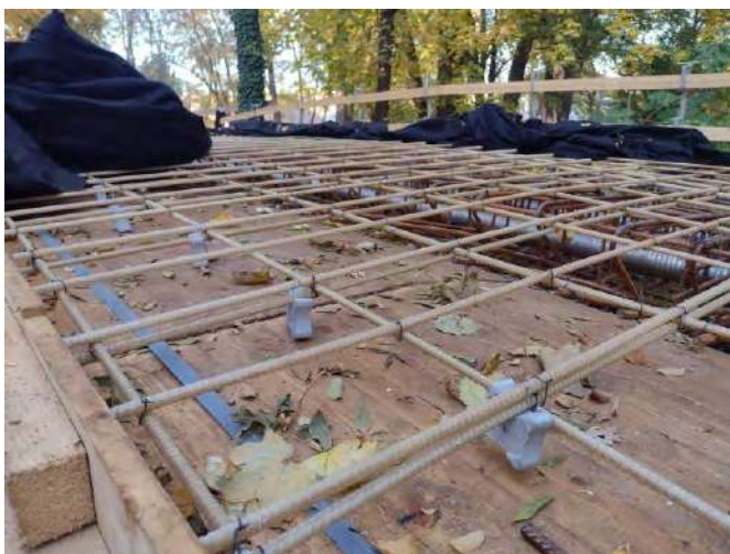
Obr. 7 Nosná GFRP výstuž v rámci konzol priečného rezu
