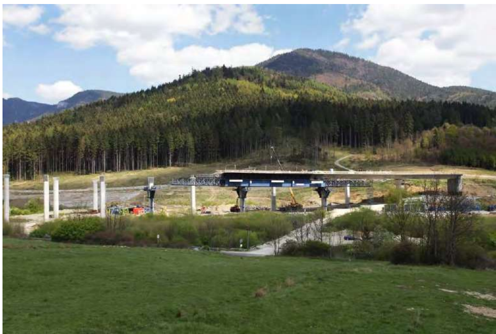
Obr. 7 – Postupná betonáž polí hlavního mostu
