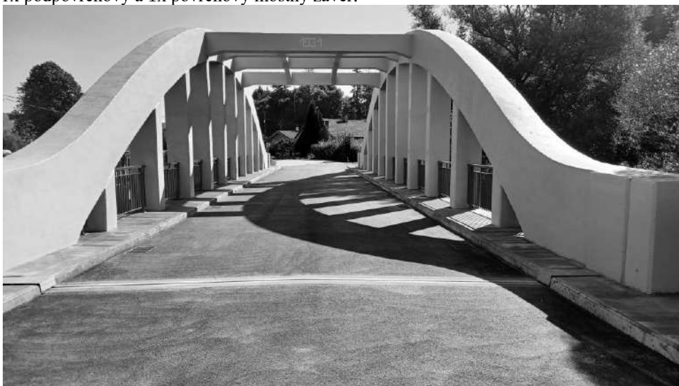
Obr. 2 Pohľad na most po rekonštrukcii
