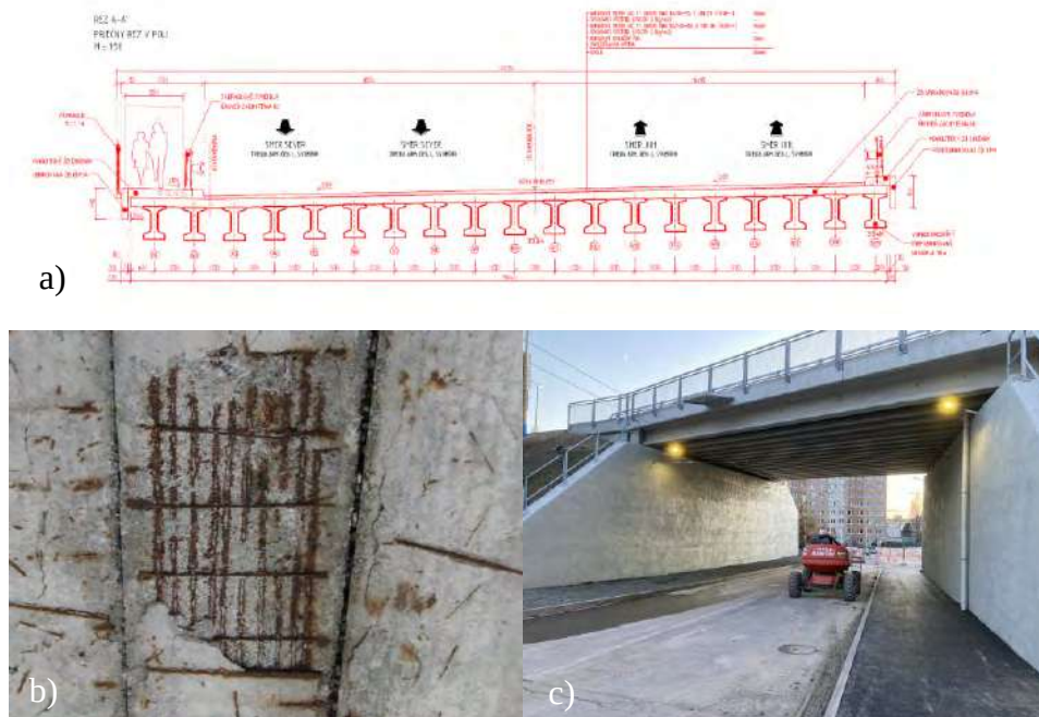
Obr. 1 – a) priečny rez rekonštruovaným mostom, b) degradácia nosníkov KA-67, c) pohľad na zrekonštruovaný most
