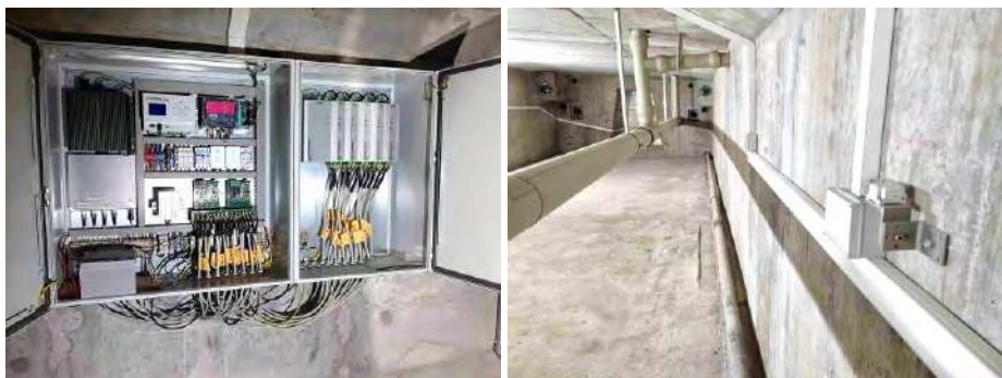
Obr. 7 Kabeláž od snímačov zvedená do meracích skriň a zapojená do PC zostavy
