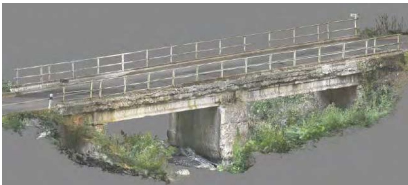
Obrázok 2: 3D axonometria scanu mosta mračnom bodov
