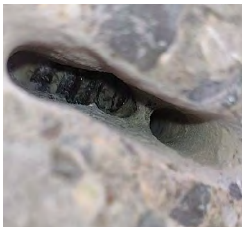
Obr. 6: Nezainjektované predpínacie laná v spodnej doske prefabrikátu; v ľavo miesto kotvenia, v pravo približne 0,5 m za kotvou.
