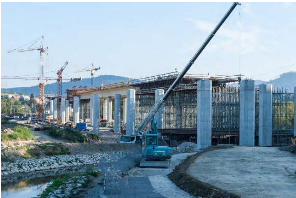
Obr. 5 Pohľad na výstavbu dvojtrámovej konštrukcie
