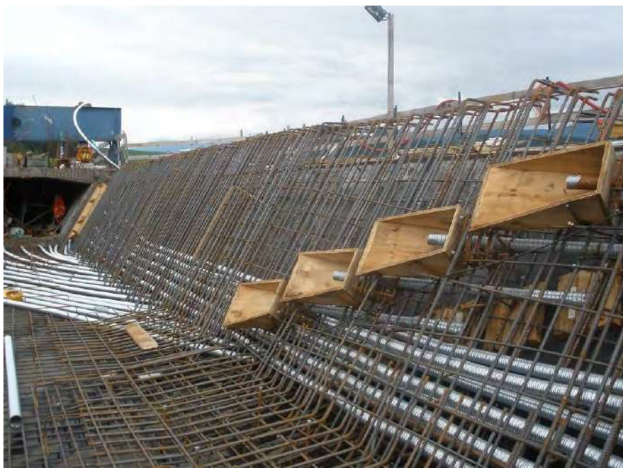
Obr. 6 – Detail napojení stěn
