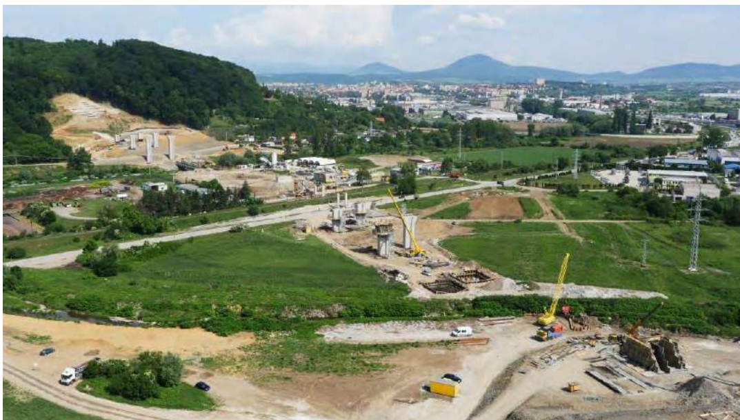
Obrázok č.1 – Spodná stavba v realizácii
