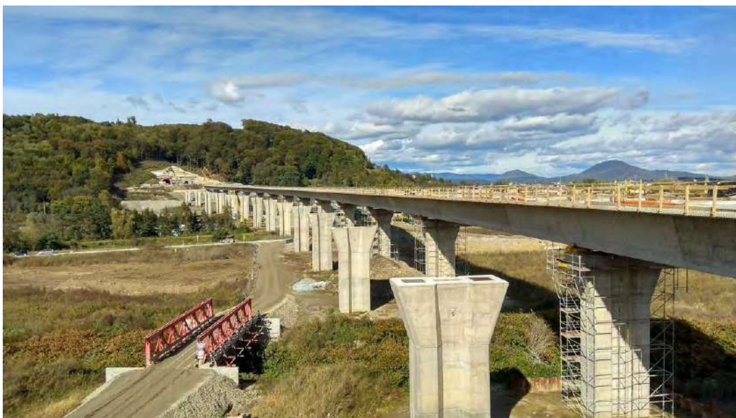
Obrázok č.2 – LM pred dokončením výsunu
