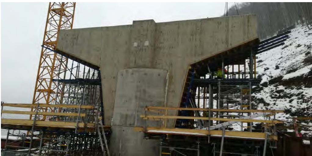
Obr. 3: Pohľad na atypickú hlavicu piliera č.2
