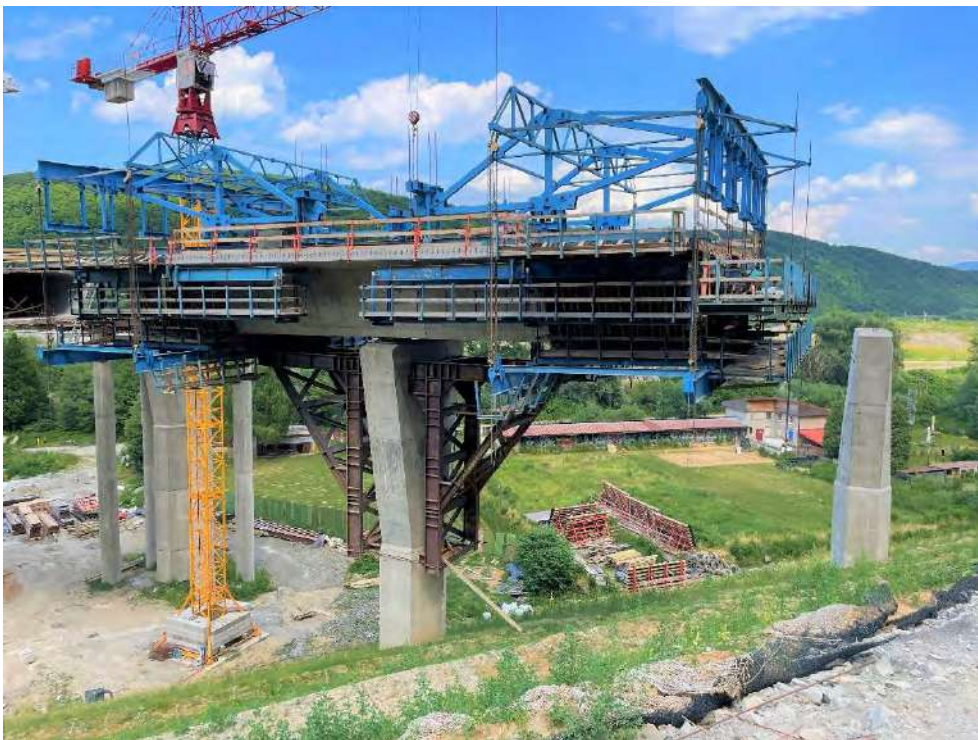
Obr. č.3 Realizácia vahadla pomocou vozíkov LB
