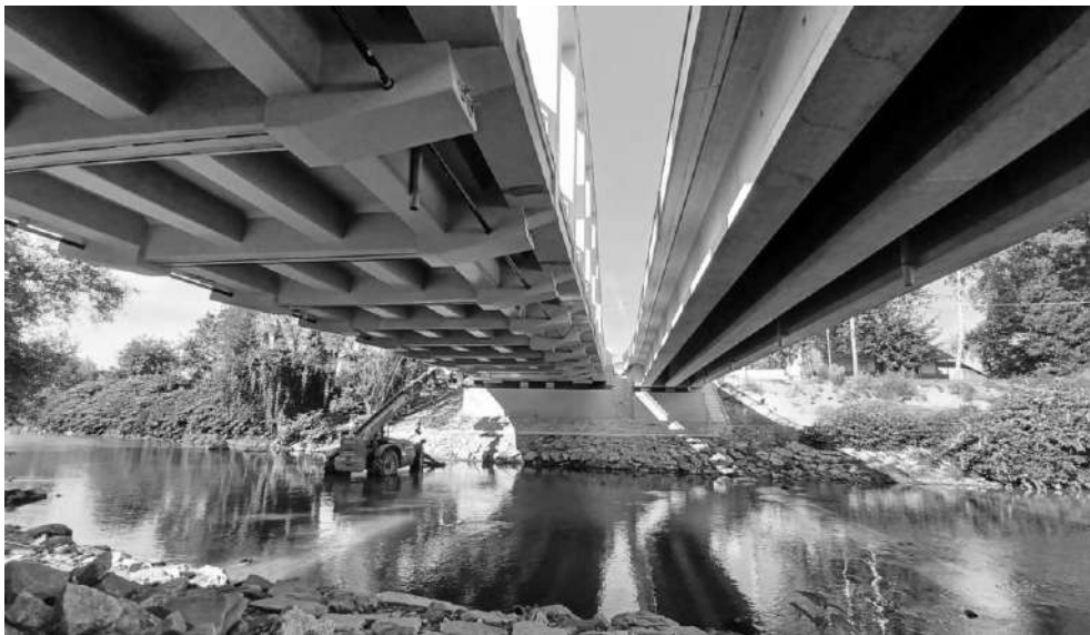
Obr. 5 Zosilnenie nosnej konštrukcie
