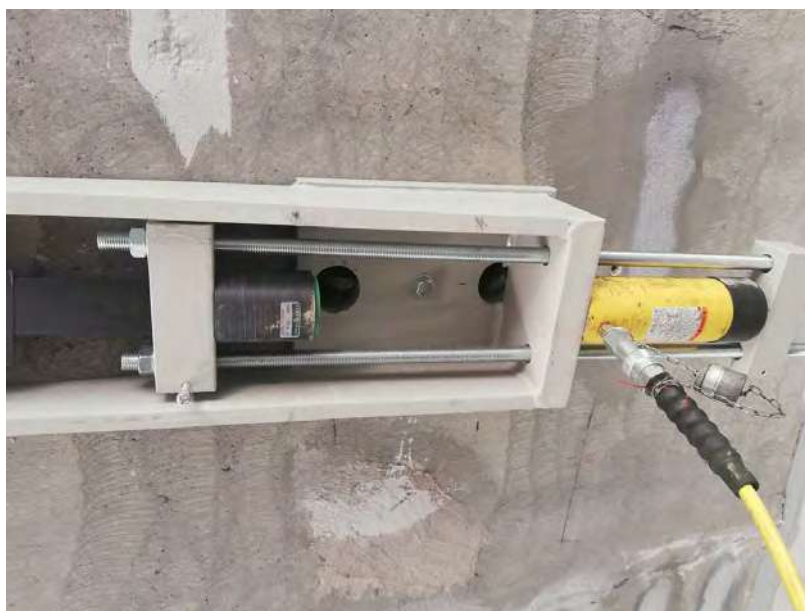
Obr. 4. Predpínanie lamely na strane aktívnej kotvy
