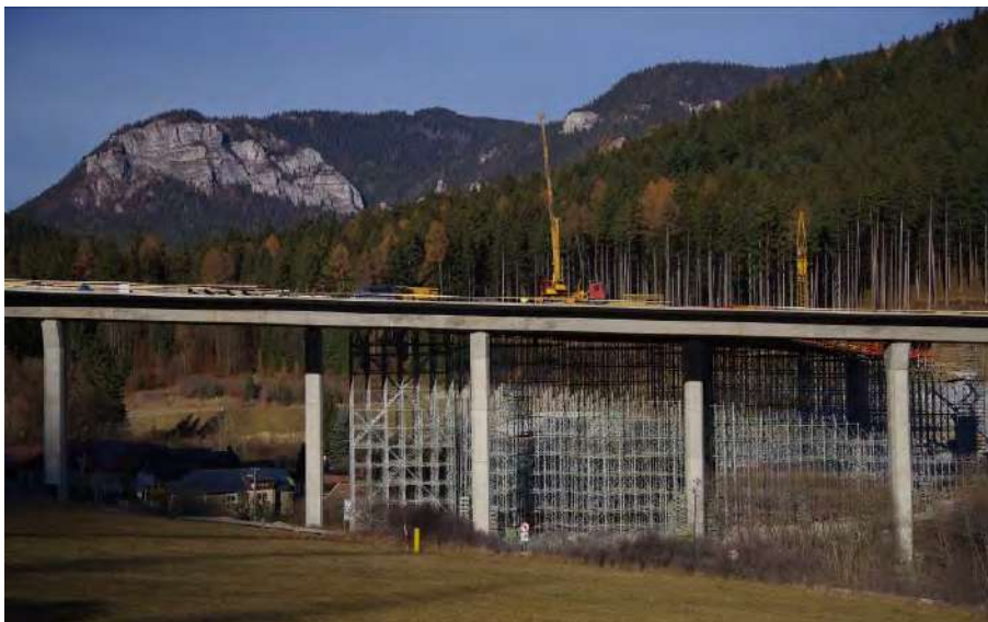
Obr. 8- Postupná betonáž polí ramp
