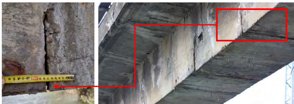
Obr. 2: Roztvorenie škár medzi segmentmi v strede poľa.
