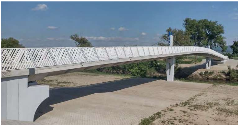
Obr. 1 Pohľad na lávku pre peších v Topolčanoch
