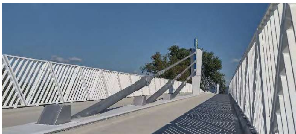
Obr. 5 Pohľad na tyčové závesy
