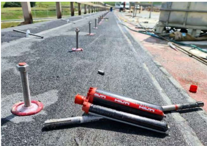
Obr. 2 Nové ukotvenie rímasy na moste 201-00 D1 Prešov, západ – Prešov, juh
