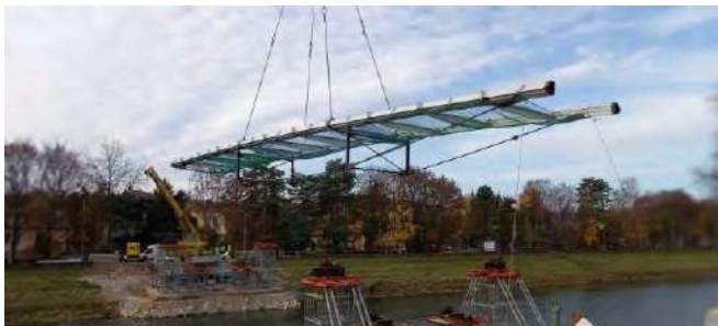
Obr. 7 – Montáž mostovky
