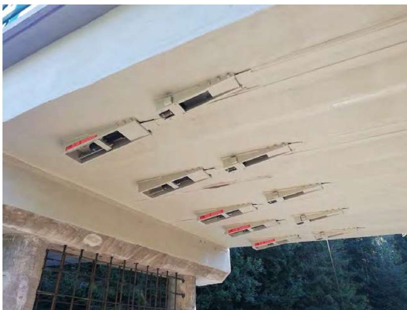
Obr. 5. Finálny pohľad na sanovaný a zosilnený most (detailný pohľad na kotvenie lamiel a deviátory)
