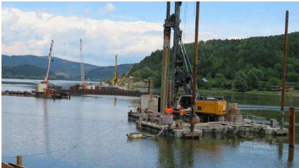
Obr. 2: Vrtanie pilót z plávajúceho pontóna
