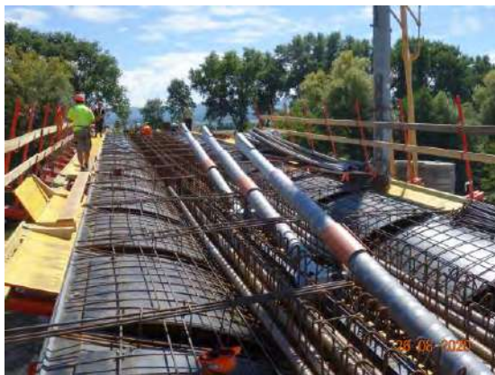
Obr. 2 Pohľad na ocelové prvky do ktorých sa následne kotvia tyčové závesy
