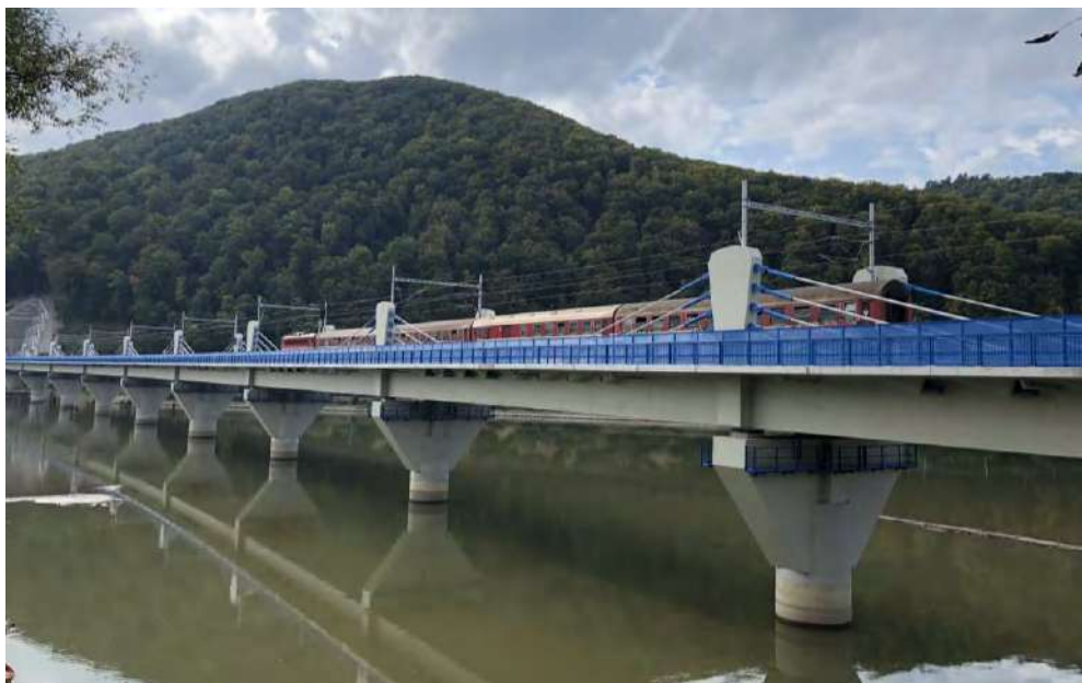
Obr. 1: Pohľad na konštrukciu
