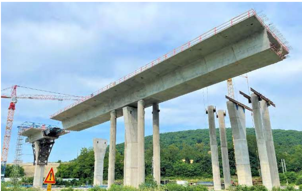
Obr. č.4 Pohľad na zrealizované vahadlo
