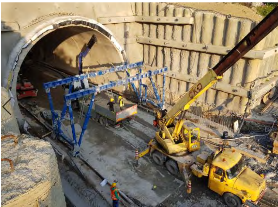
Obr. 2: Osadzovanie zmontovaných priečnych rámov tunelového debniaceho vozíka DokaCC priamo na koľajnicovú dráhu pomocou mobilného žeriavu.
