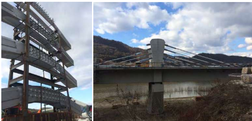
Obr. 5: Osadenie prípravkov DYNA® Link Anchor Box (vľavo) a samotná montáž extrasosových káblov (vpravo)
