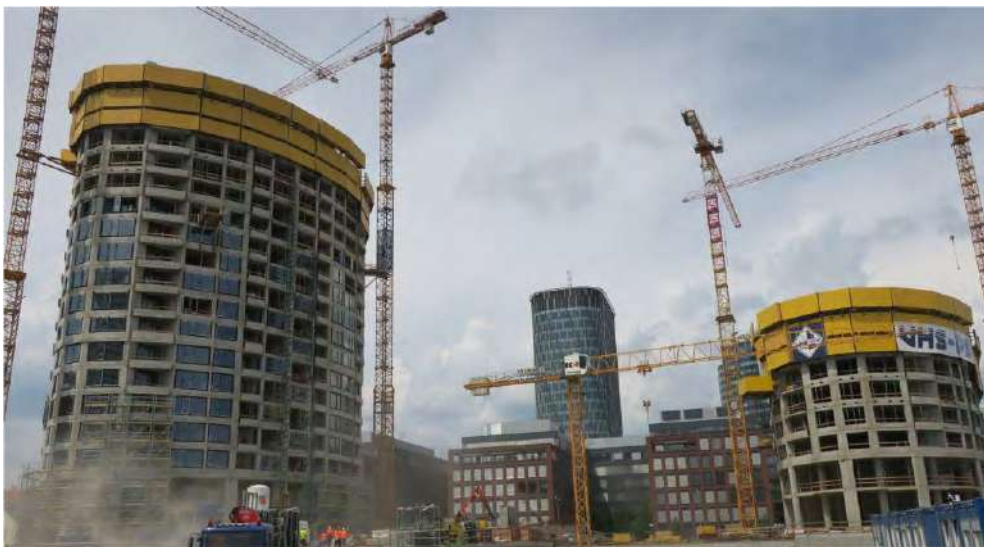
Obr. 3: Použitie Doka veterných štítov Xclimb 60 pri výstavbe dvoch identických veží multifunkčného projektu SKY PARK
