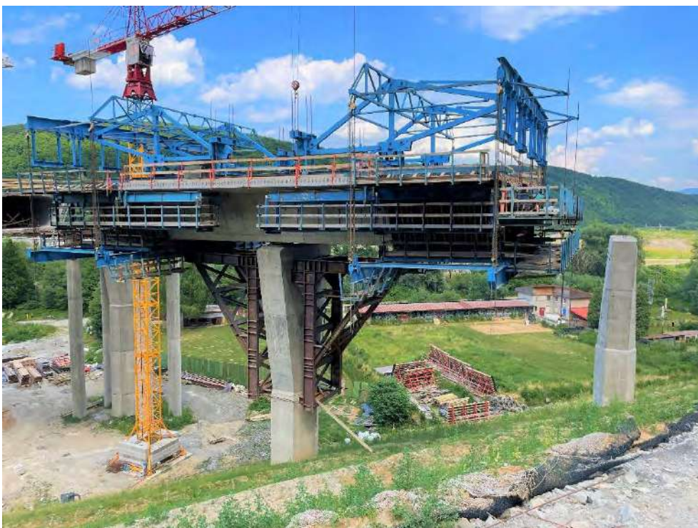
Obr. č.3 Realizácia vahadla pomocou vozíkov LB
