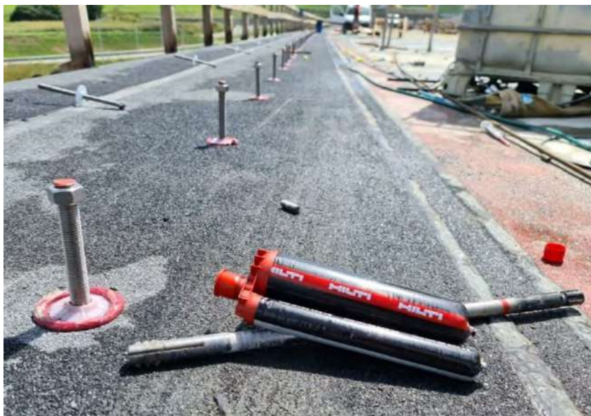
Obr. 2 Nové ukotvenie rímsy na moste 201-00 D1 Prešov, západ – Prešov, juh
