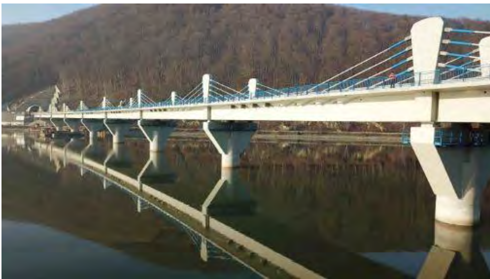
Obr. č. 6 Estakáda pred dokončením
