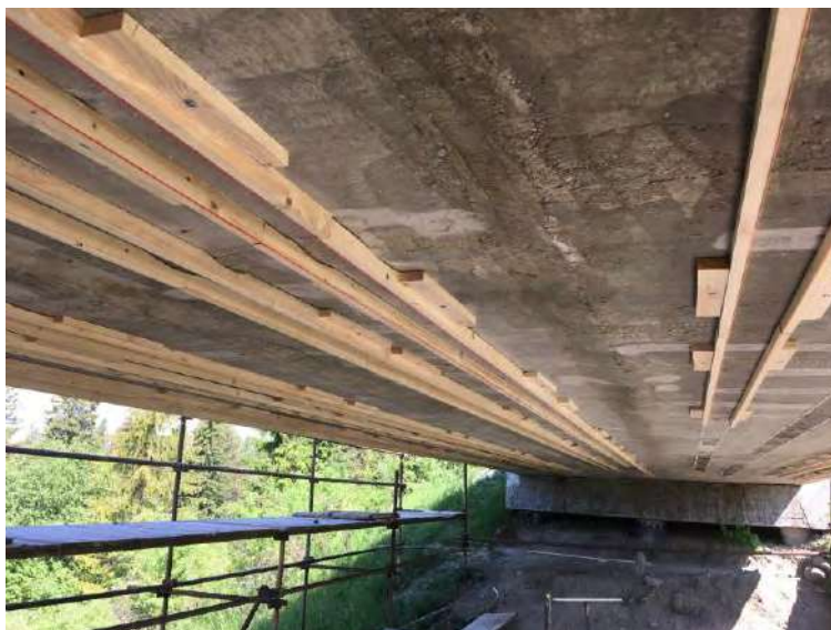
Obr. 1. Príprava priestoru na sanáciu podkladu pred zosilňovaním
