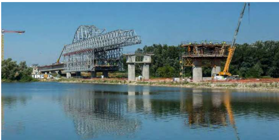
Obr. 3 Výstavba komôrkového jadra nosnej konštrukcie technológiou výsuvnej skruže
