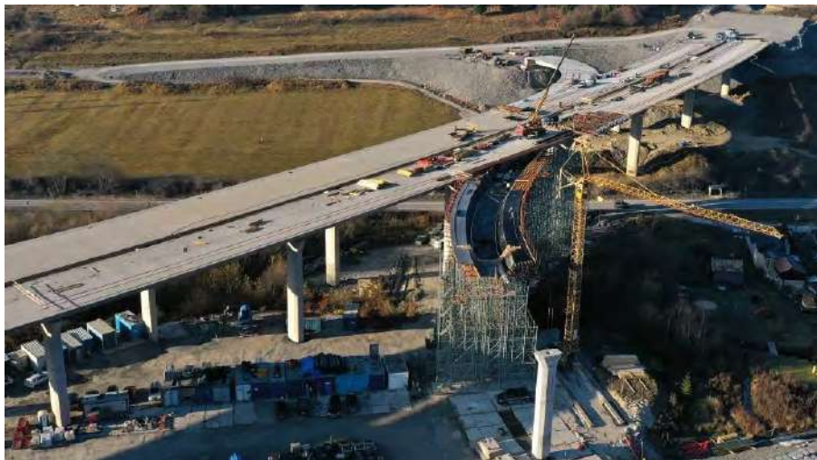
Obr. 8 – Postupná betonáž polí ramp
