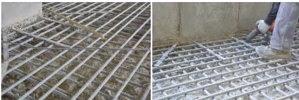
Obr.4 Odstraňovanie poškodenej vrstvy ŽB dosky
