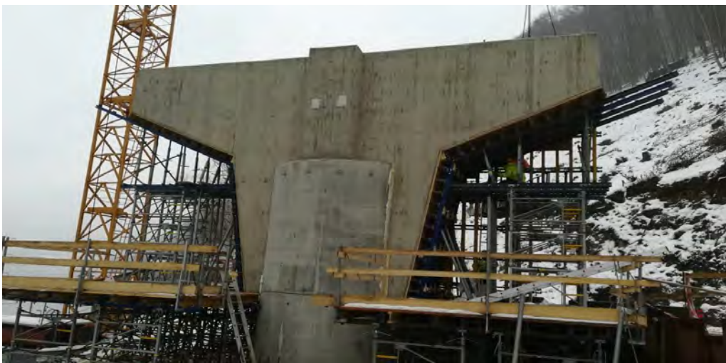
Obr. 3: Pohľad na atypickú hlavicu piliera č.2
