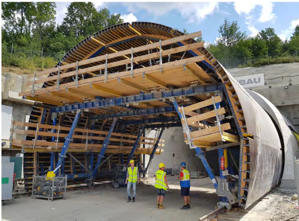
Obr. 4: Vstupný portál tunela Diel - úsek K1 zhotovený pomocou debniaceho vozíka DokaCC.
