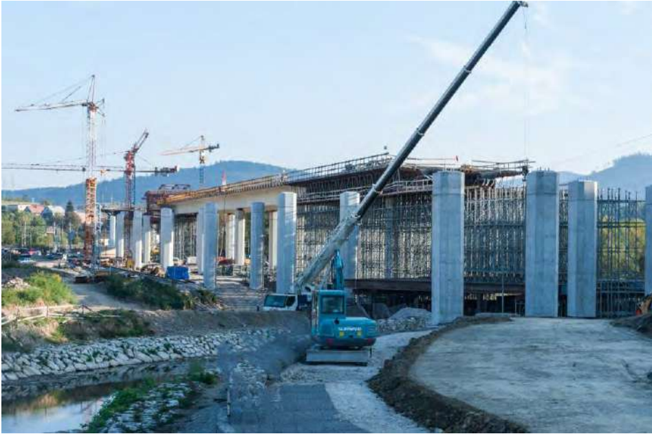
Obr. 5 Pohľad na výstavbu dvojtrámovej konštrukcie
