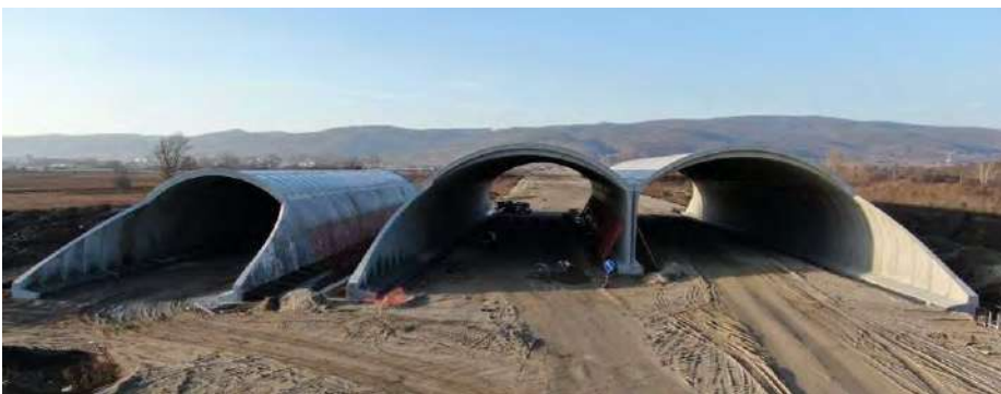
Obr. 6) Poslední objekt na SO204.1 a SO204.2 – 12.12.2019 The last structure SO204.1 and SO204.2 – 12.12.2019
