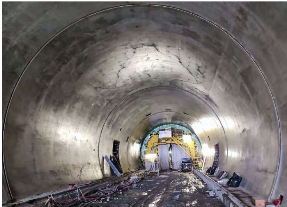
Obr. 6 Pohľad na vybetónovaný blok sekundárneho ostenia
