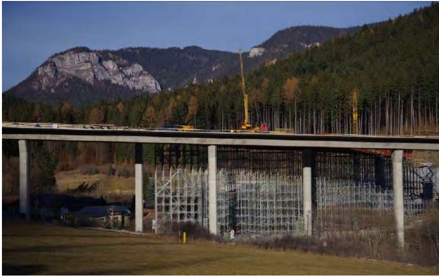
Obr. 8- Postupná betonáž polí ramp
