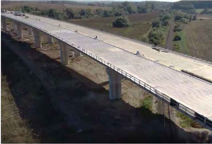
Obr. 10 Most na R2 nad žel. traťou a Krivánskym potokom
