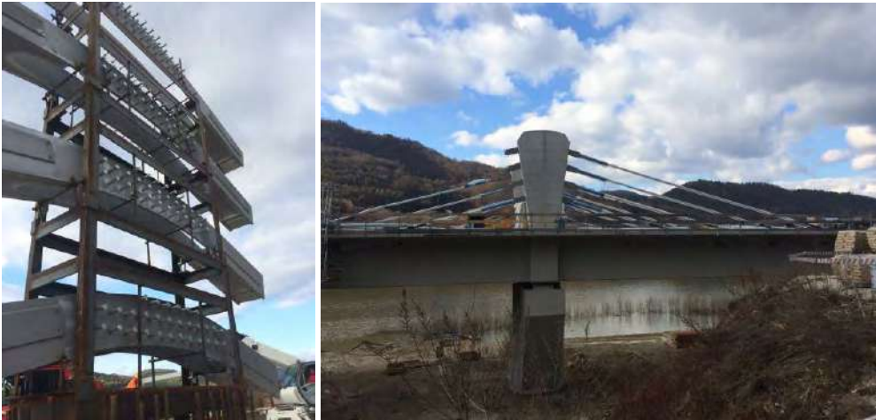
Obr. 3: Osadenie prípravkov DYNA® Link Anchor Box (vľavo) a samotná montáž extradosových káblov (vpravo)
