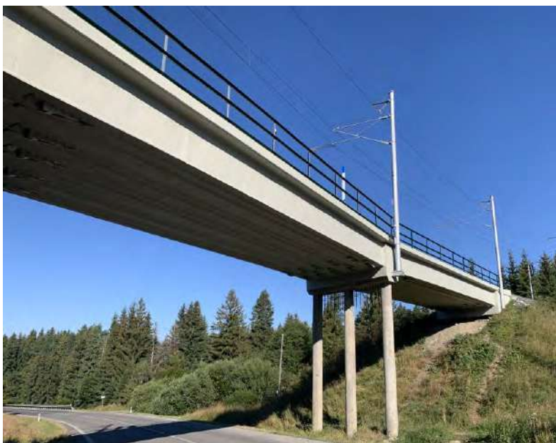
Obr. 6 Finálny pohľad na sanovaný a zosilnený most (pred betonážou medzi piliermi)
