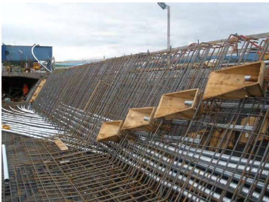
Obr. 6 – Detail napojení stěn
