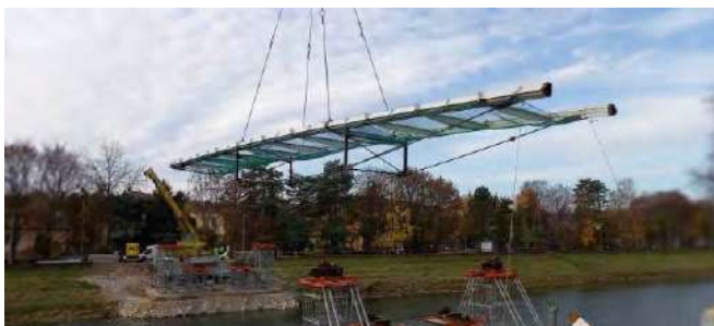
Obr. 7 – Montáž mostovky
