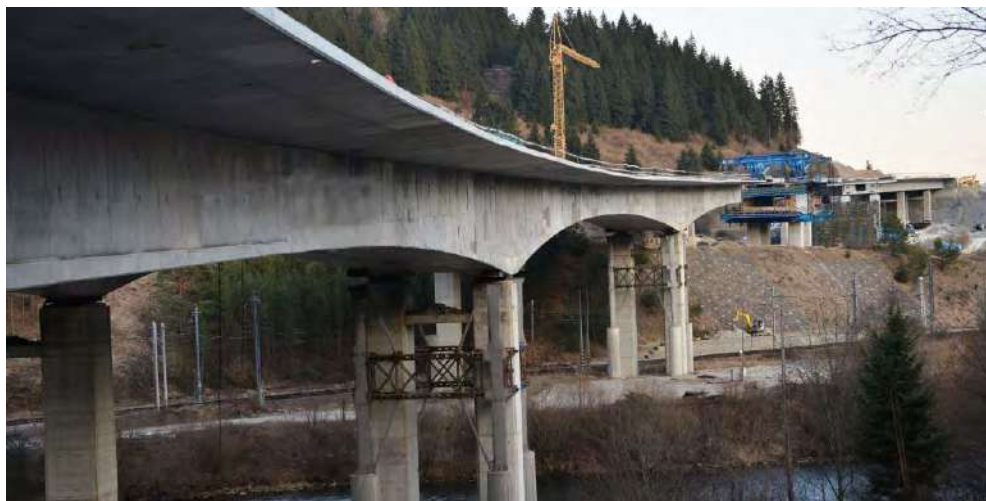
Obr.6 Pohľad na rozostavanú časť nosnej konštrukcie
