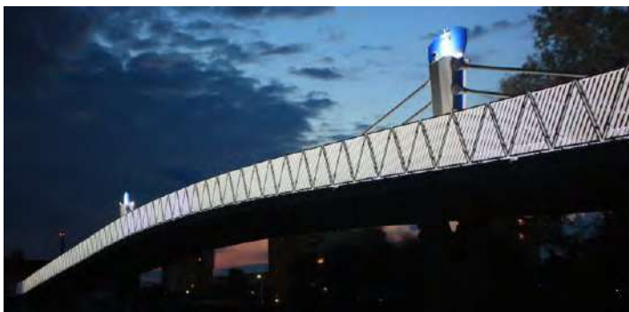
Obr. 4 Pohľad na lávku pre peších v Topoľčanoch v noci
