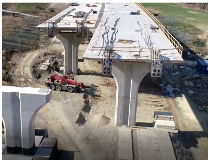
Obr. 8 Most na R2 nad žel. traťou a cestou I/16 v km 9,441 - 9,957
