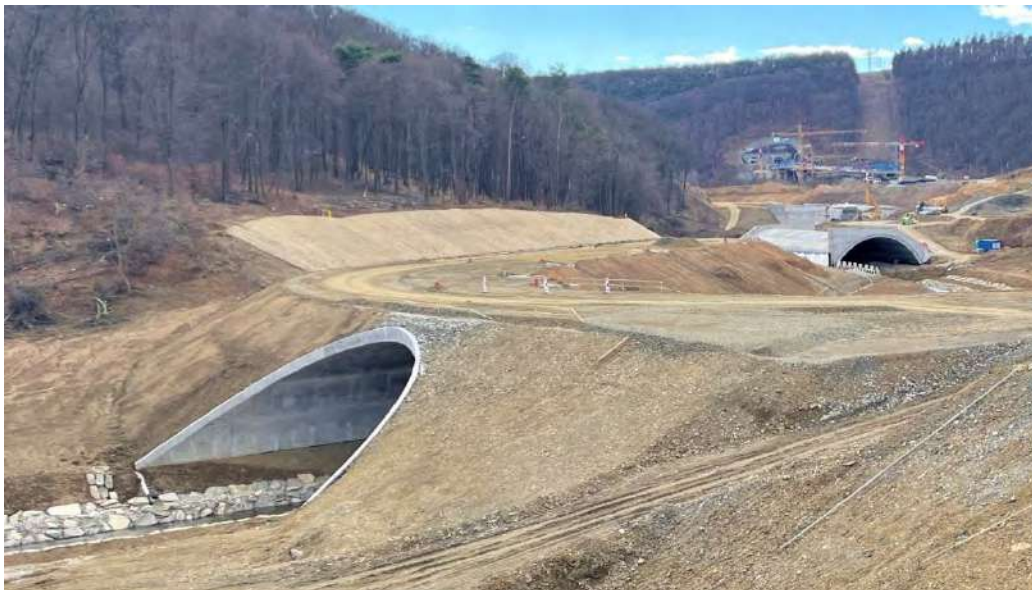
Obrázok 7. Pohľad na presypaný mostný objekt SO 232 so zrealizovanou časťou preložky potoka Dzikov (SO 322), v pozadí zabetónovaný mostný objekt SO 233
