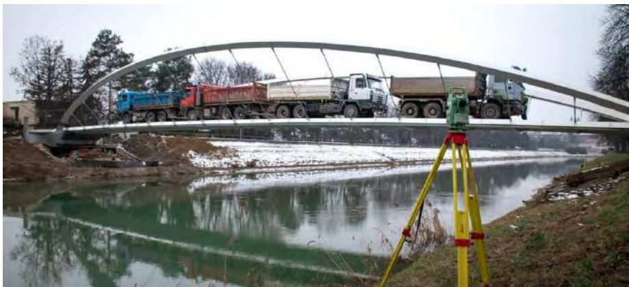
Obr. 10 – Statická zatěžovací zkouška
