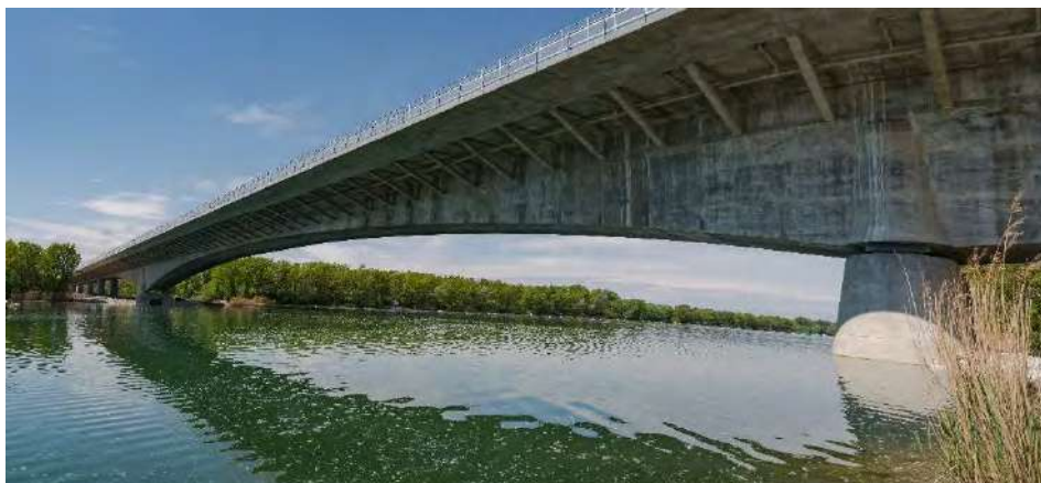
Obr. 4. Pohľad na dokončený mostný objekt
