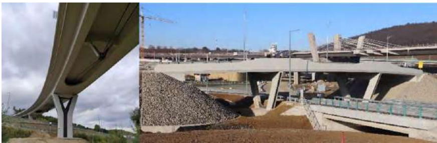
Obr. 4 Pohľad na mostný objekt 208-00 a mostný objekt 213-00 (v pozadí most 201)
