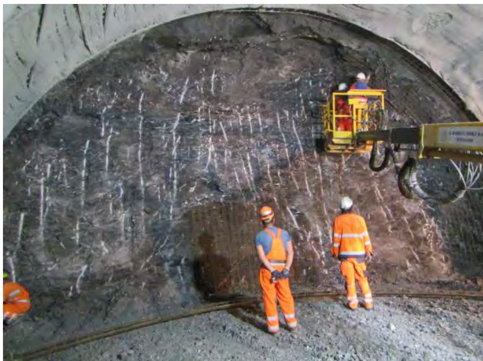
Obr. 4 Čelba vo vstrojovacej triede VT 4/2
