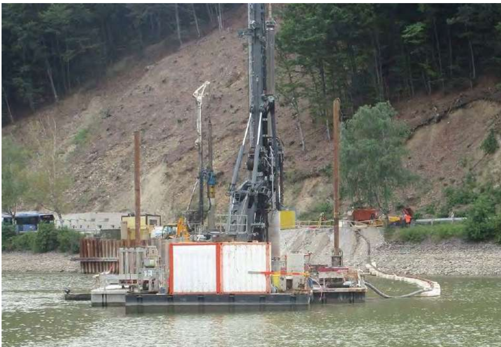
Obr. č. 2 Vrtanie pilót z plávajúcej pontónovej súpravy
