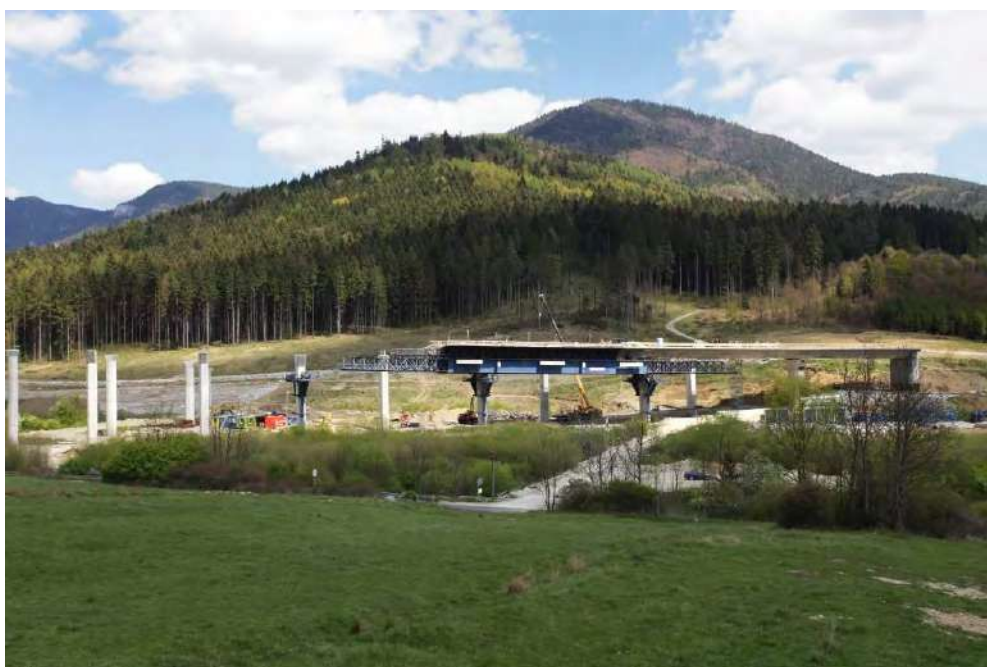
Obr. 7 – Postupná betonáž polí hlavního mostu
