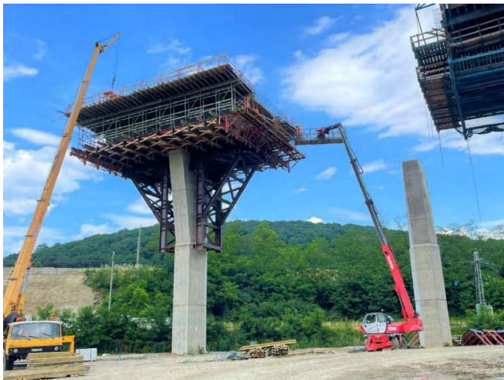
Obr. č.2 Pohľad na podopretie zárodku pomocou oceľových konštrukcie
