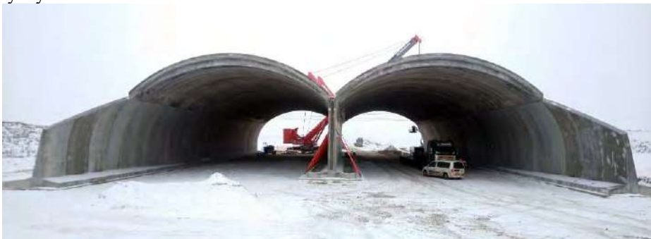
Obr. 4) Poslední den montáže prvního mostu SO207 – 21.12.2018 The last day of install of the first bridge SO207 – 21.12.2018
