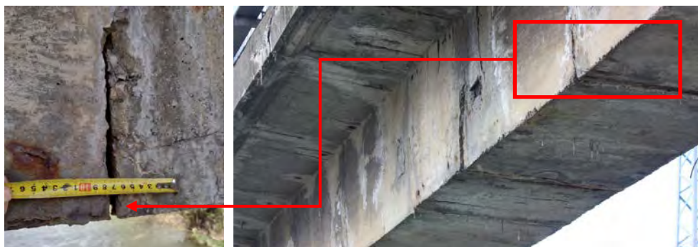
Obr. 2: Roztvorenie škár medzi segmentmi v strede poľa.
