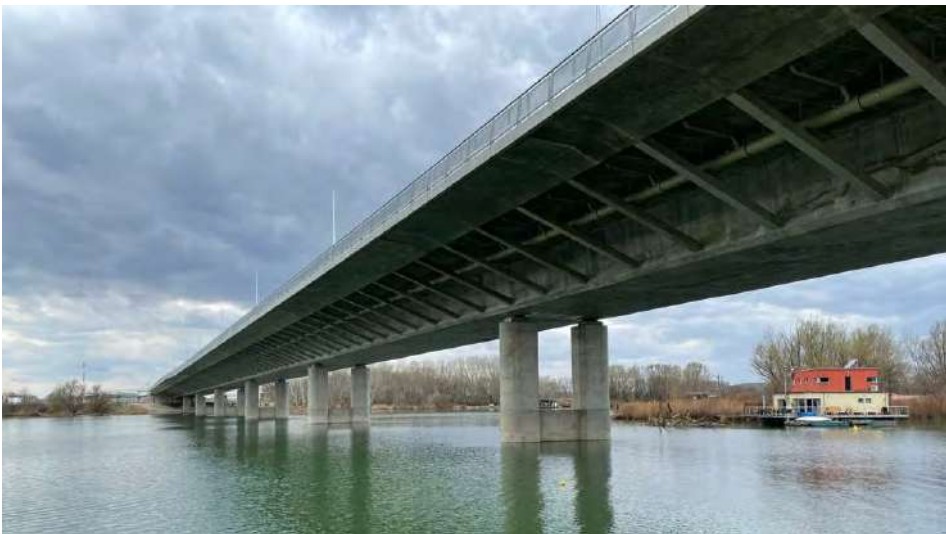
Obr. 5 Pohľad na most nad Jaroveckým ramenom
