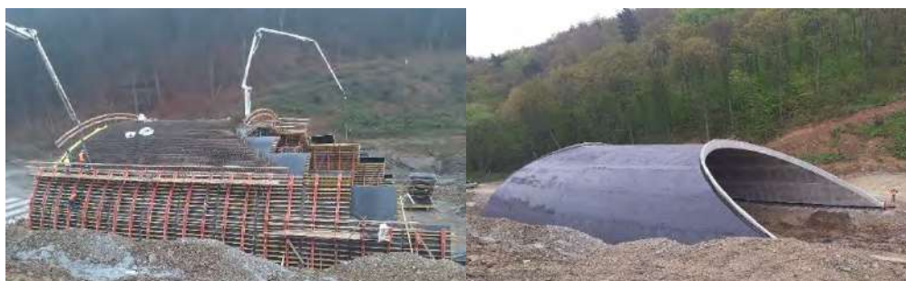
Obrázok 6. Realizácia I. dilatačného celku nosnej konštrukcie a hotový zaizolovaný celý mostný objekt SO 232
