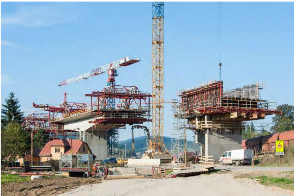
Obr. 6 Pohľad na výstavbu komorovej konštrukcie
