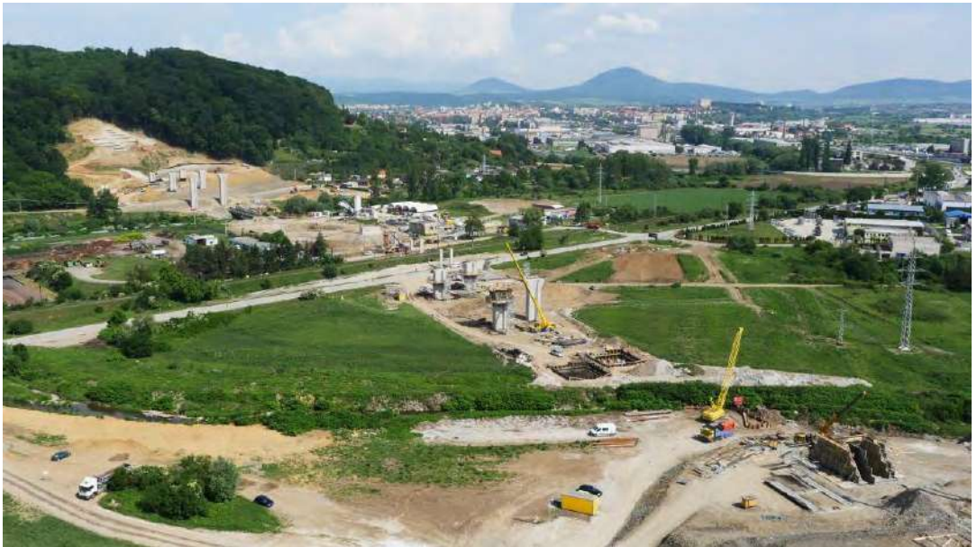
Obrázok č.1 – Spodná stavba v realizácii
