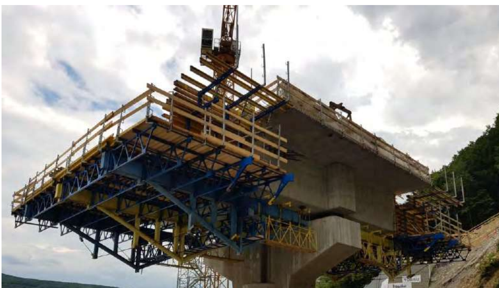
Obr. č. 5 Montáž vozíkov letmej betonáže
