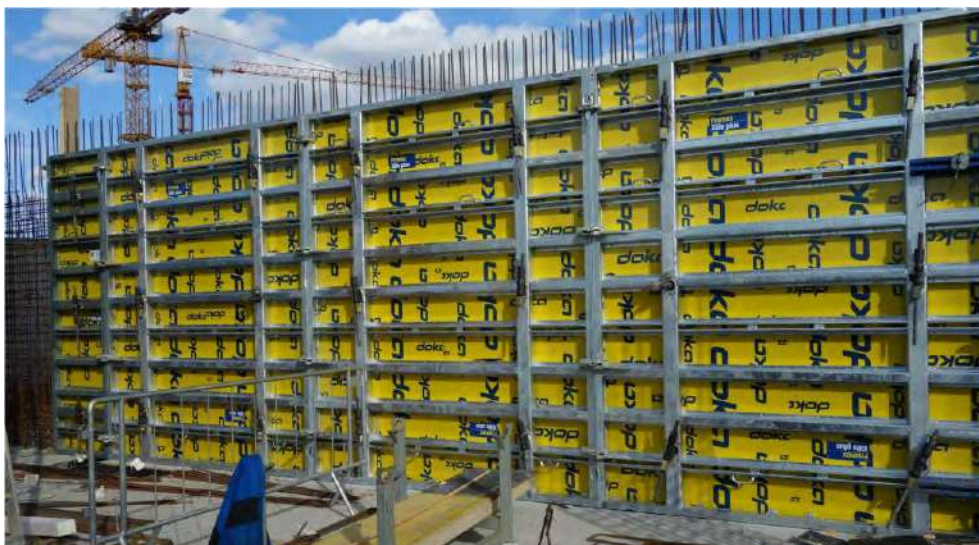
Obr. 1: Nové rámové debnenie Framax Xlife plus s jednostranne ovládateľnou kotvou a veľkoplošnými panelmi s rozmerom 2,7 x 3,3 m
