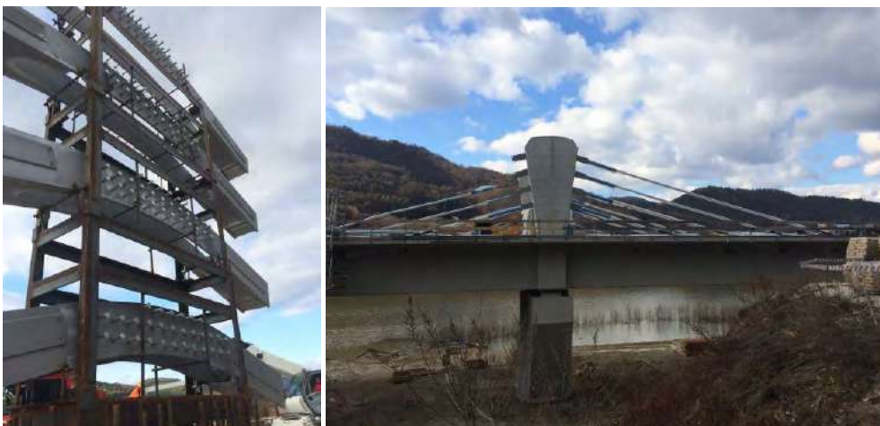
Obr. 5: Osadenie prípravkov DYNA® Link Anchor Box (vľavo) a samotná montáž extrasadosových káblov (vpravo)
