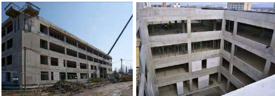
Obr. 1 Pohľad na riešený objekt
