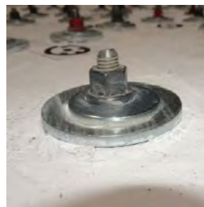
Obr. 2 Použitá šmyková výstuž
