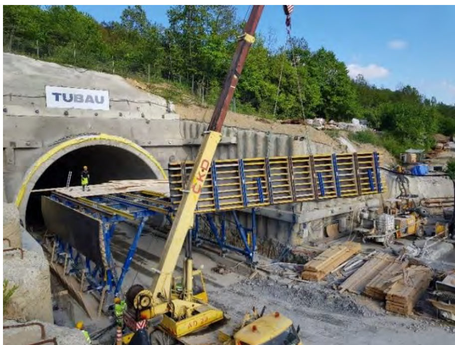
Obr. 3: Montáž vopred zhotovených vnútorných panelov Top50 a ich prichytenie na debniaci vozík DokaCC.
