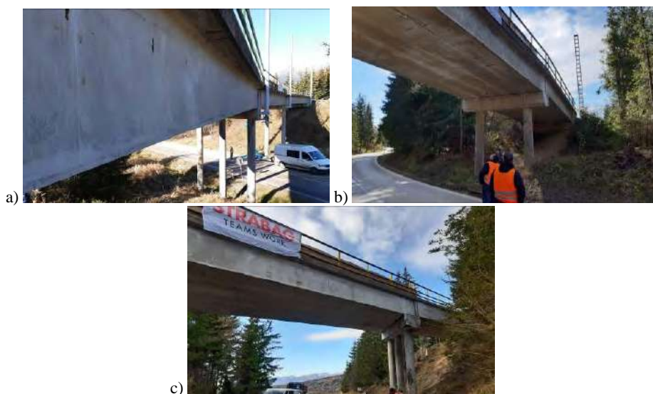
Obr. 1 Pohľad na posudzované mostné objekty – most č. 1 (a), most č. 2 (b) a most č. 3 (c)
