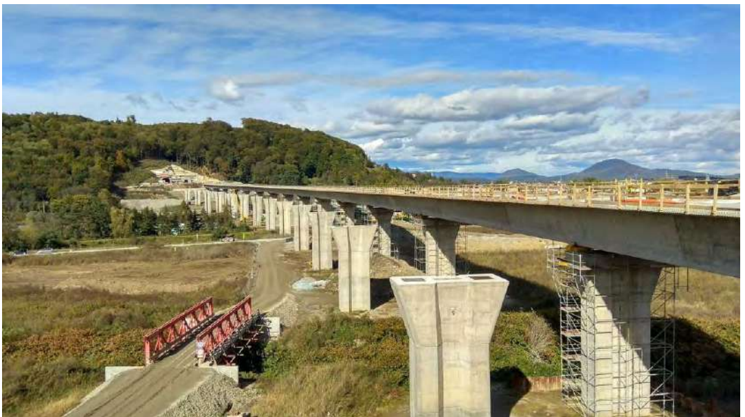
Obrázok č.2 – LM pred dokončením výsunu
