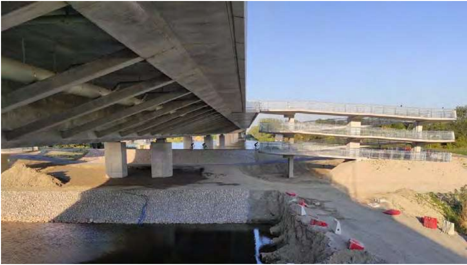
Obr. 6 Pohľad na most nad Jaroveckým ramenom a prístupovú lávku pre peších a cyklistov
