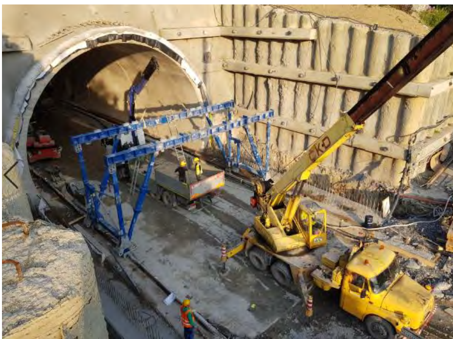
Obr. 2: Osadzovanie zmontovaných priečných rámov tunelového debniaceho vozíka DokaCC priamo na koľajnicovú dráhu pomocou mobilného žeriavu.
