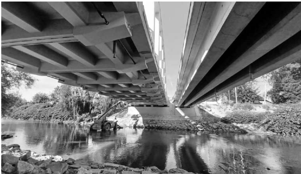
Obr. 5 Zosilnenie nosnej konštrukcie
