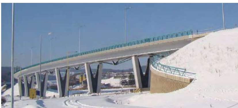
Obr. 2 Pohľad na mostný objekt 215-00 po dobudovaní 1.etapy križovatky
