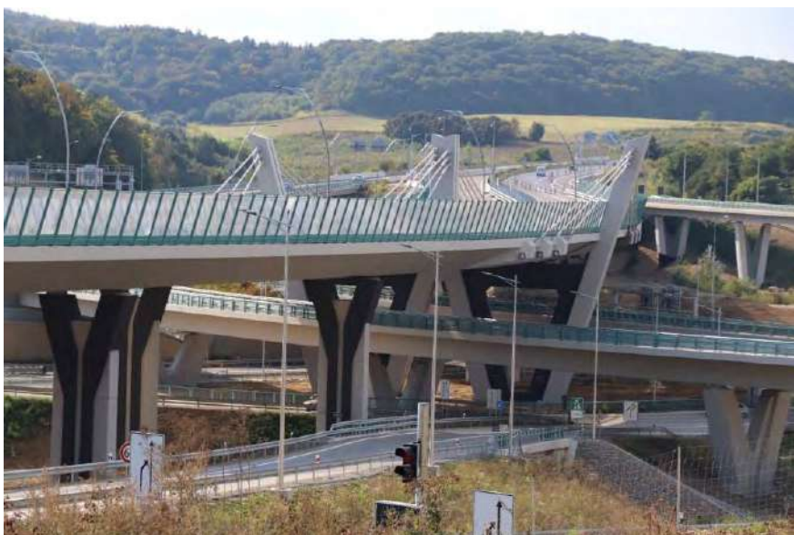
Obr. 6 Pohľad na dokončený mostný objekt 201-00
