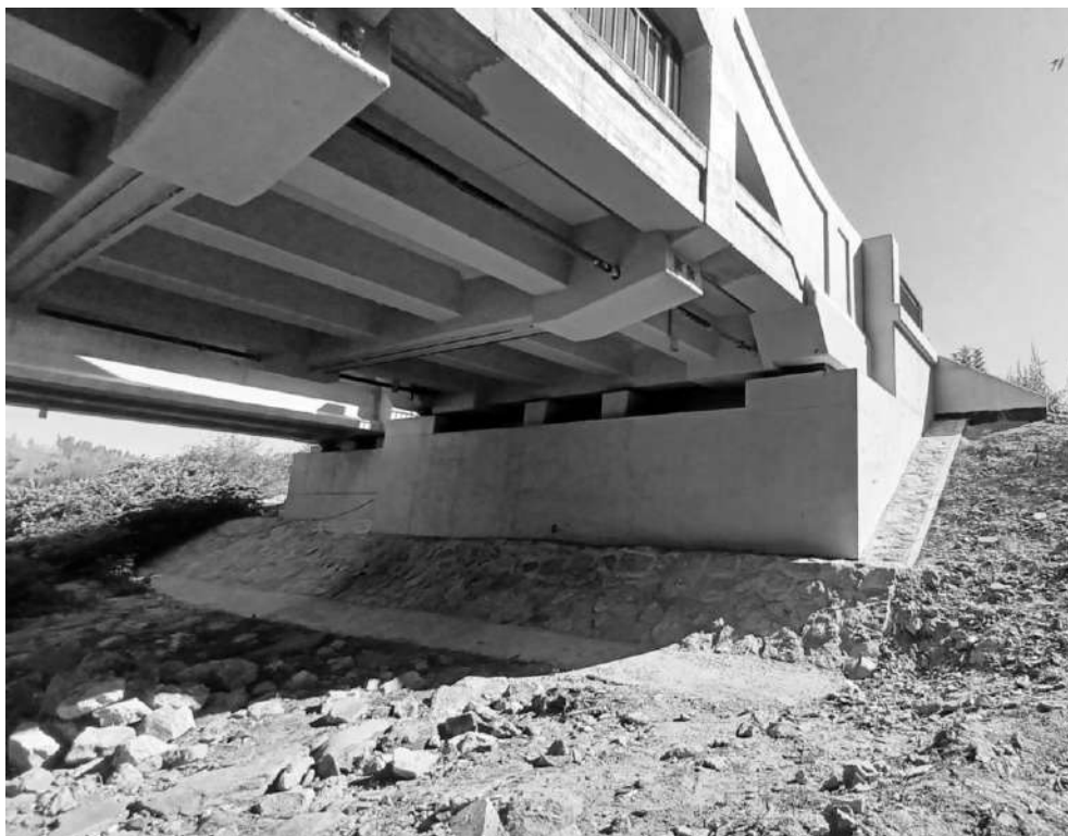
Obr. 4 Pohľad na oporu
