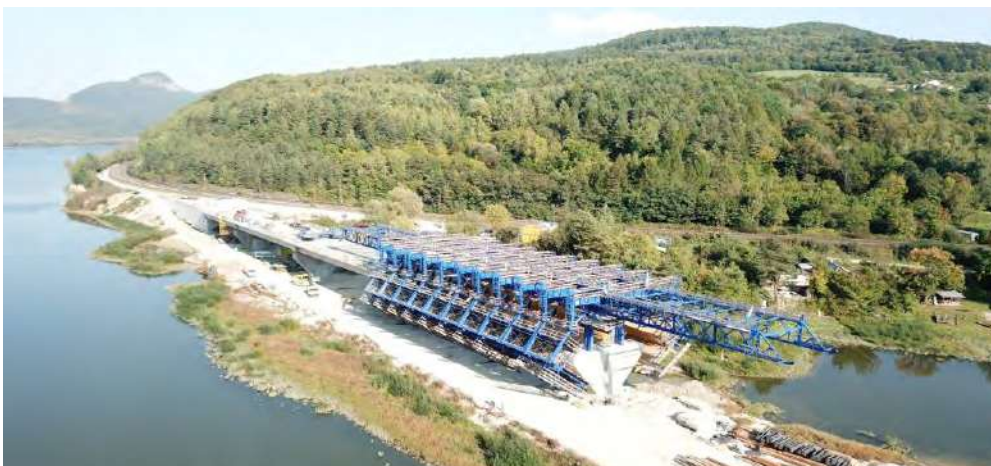
Obr. č. 4 Pohľad na výsuvnú skruž počas presunu
