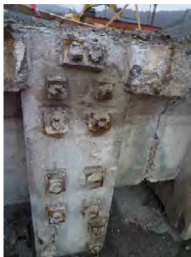
Obr. 4 a) Most Podbiel – kotevná oblasť, b) Most Nižná – detail odkorodovaných káblov, nefunkčná dvojkotva
