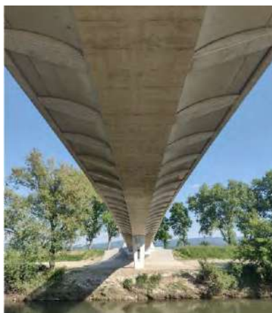
Obr. 3 Pohľad na lávku pre peších v Topoľčanoch spod mosta
