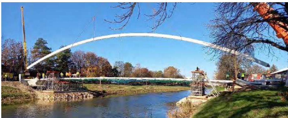
Obr. 9 – Montáž oblouku
