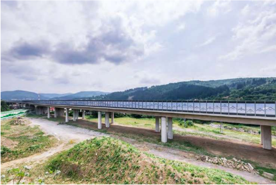
Obr. 7 Pohľad na dokončený most
