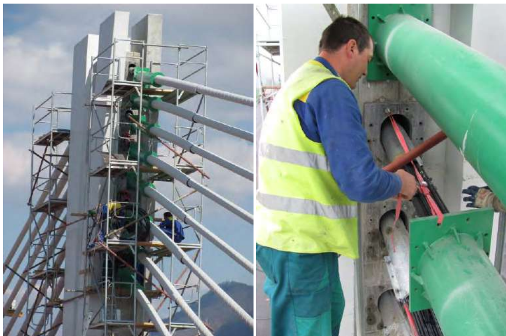
Obr. 2: Ukážka z realizácie konvenčných sediel z projektu: estakáda Považská Bystrica budovaná v rámci úseku DISverepec – Vrtižer z roku 2010
