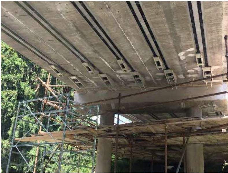
Obr. 3. Pohľad na zabudované lamely (na každom nosníku dvojica lamiel s prestriedaním aktívna / pasívna kotva)
