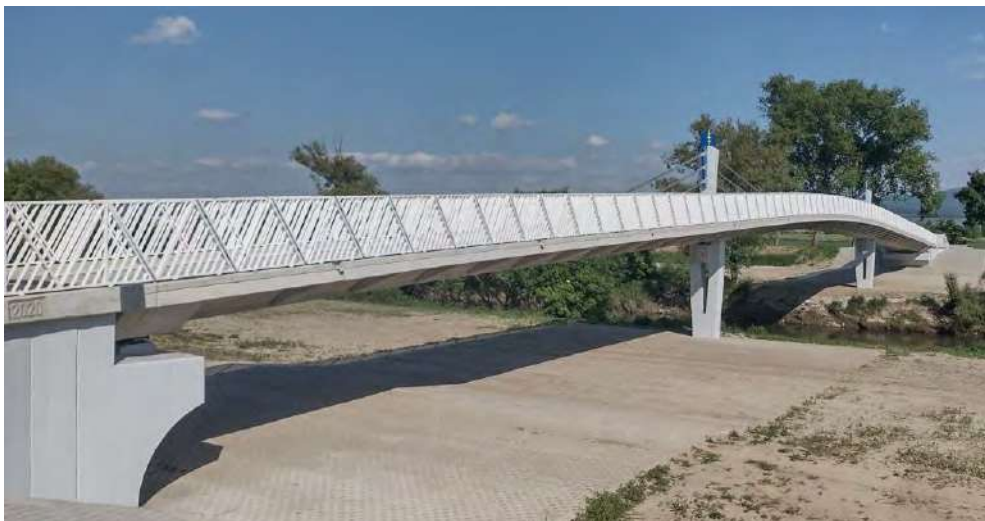
Obr. 1 Pohľad na lávku pre peších v Topolčanoch
