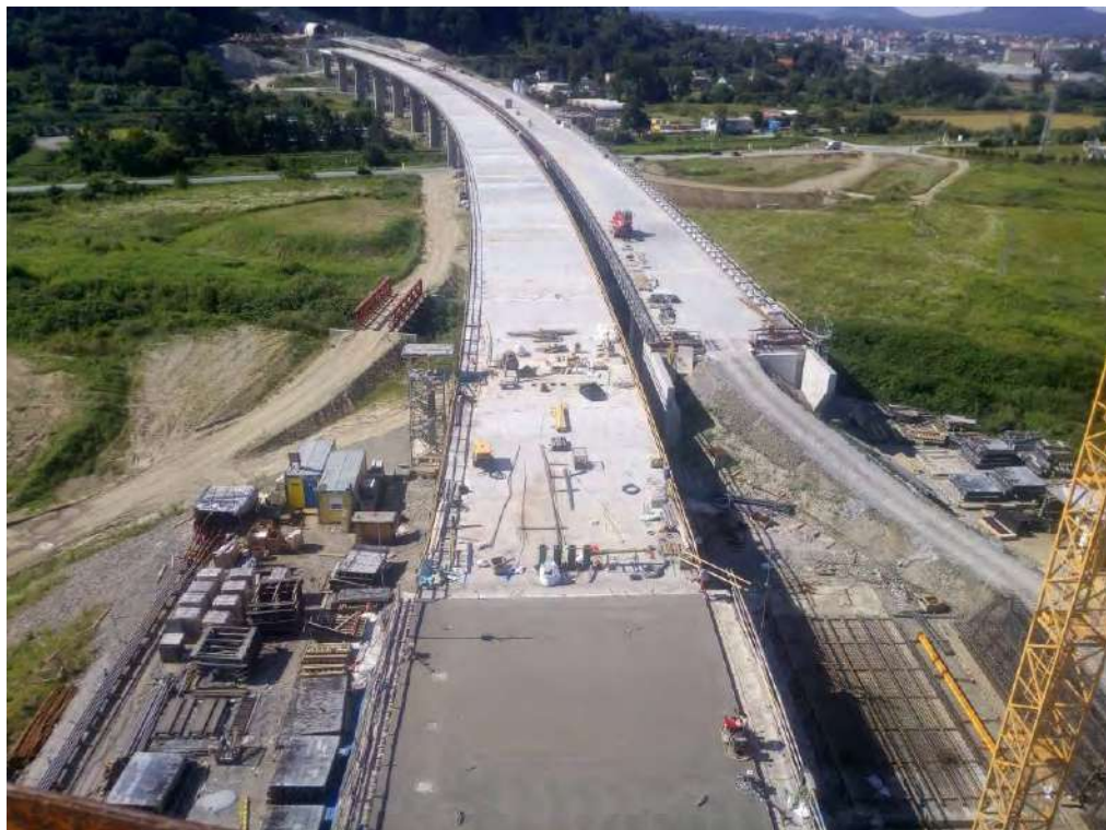
Obrázok č.4 – Ukončená betonáž vo výrobni
