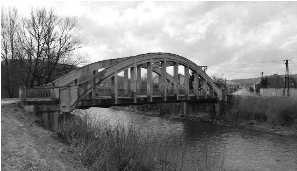
Obr. 1 Pohľad na most pred rekonštrukciou
