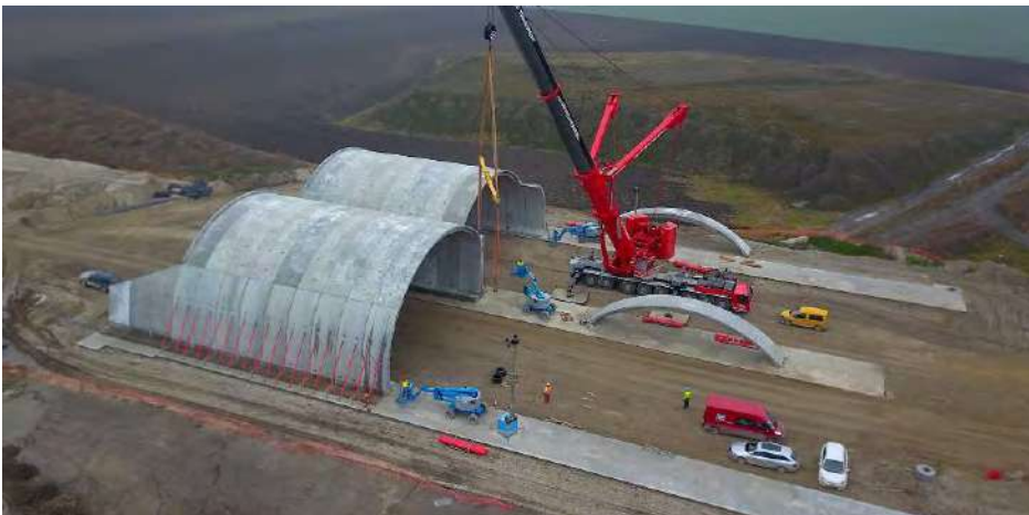
Obr. 5) Letecký záběr průběhu montáže – výstavba NK mostu probíhá pouze 2 týdny Aerial view of the installation which takes only 2 weeks
