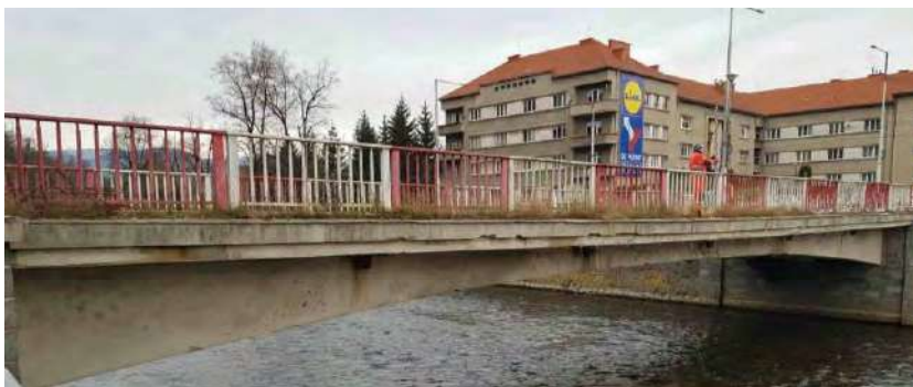
Obr. 1 – Pohľad na overovaný most v Banskej Bystrici.
