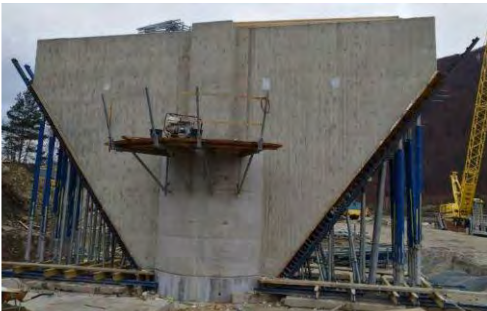
Obr. č. 3 Pohľad na zabetónovanú hlavicu piliera
