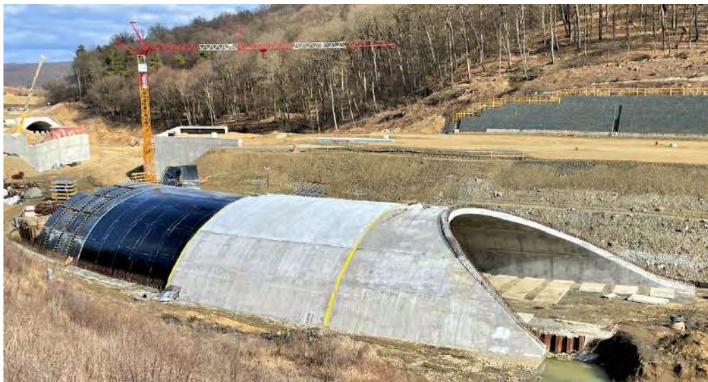
Obrázok 5. Postupná realizácia mostného objektu SO 214 v zmysle schválenej etapizácie
