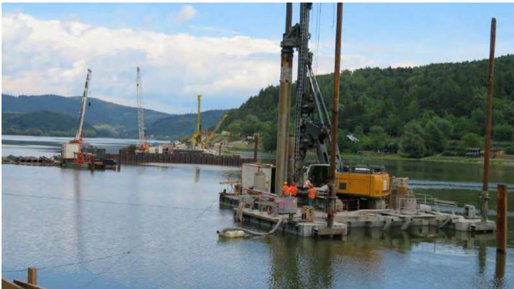
Obr. 2: Vrtanie pilôt z plávajúceho pontóna
