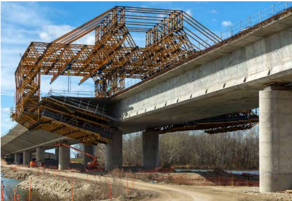
Obr. 4 Výstavba konzol nosnej konštrukcie pomocou posuvnej skruže
