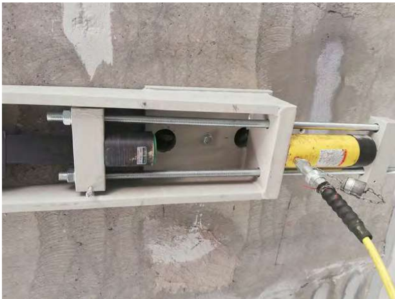
Obr. 4 Predpínanie lamely na strane aktívnej kotvy
