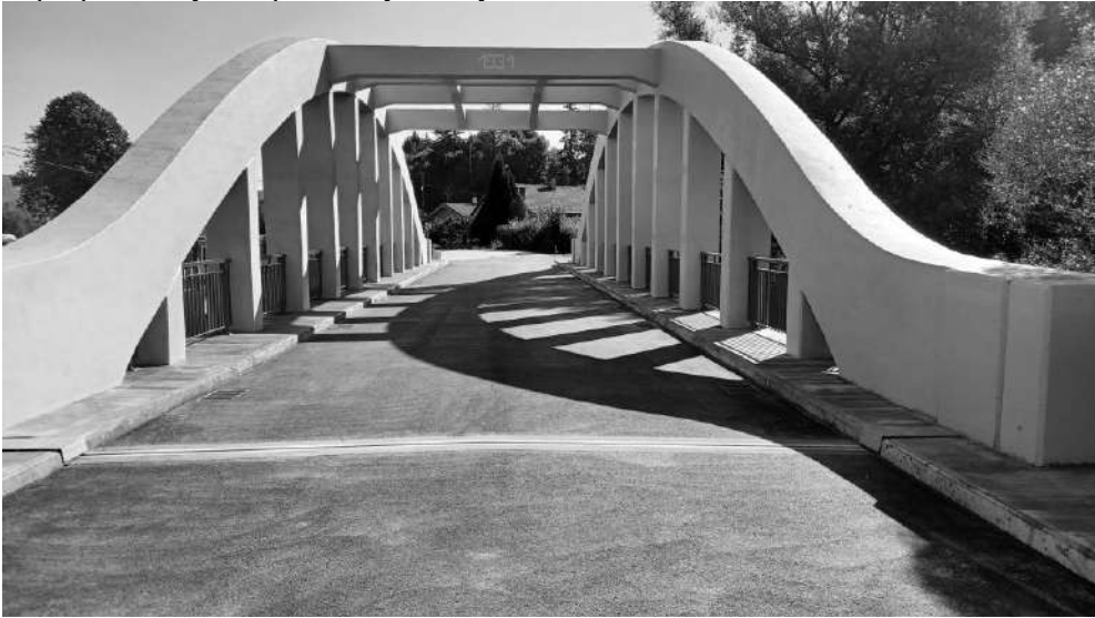
Obr. 2 Pohľad na most po rekonštrukcii
