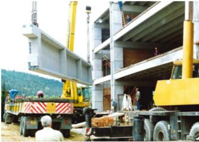
Predpätý väzník – Pavilón E, Brno, ČR (1991)
